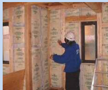
断熱材施工時*
