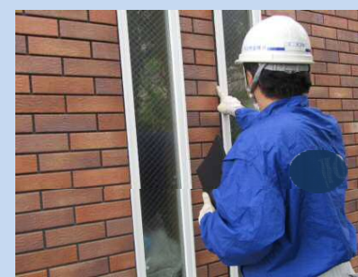
建物本体工事完了時*
