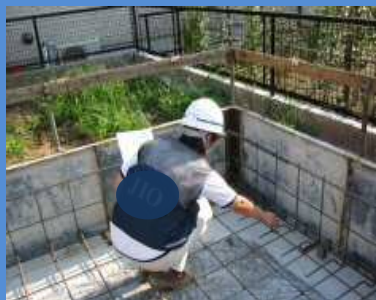
基礎配筋工事の完了時*
