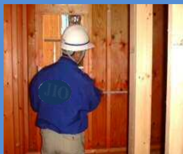
躯体工事の完了時*
